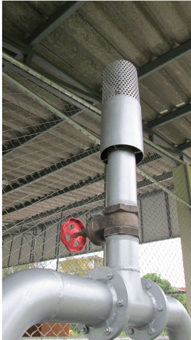
รูปที่ 3.12 อุปกรณ์ประกอบระบบผลิตไฟฟ้าด้วยเครื่องยนต์ชีวมวล: หัวเผาทดลองแก๊ส
