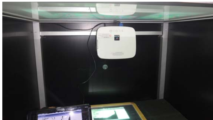
ภาพที่ 4.46 การติดตั้งโปรเจ็คเตอร์
