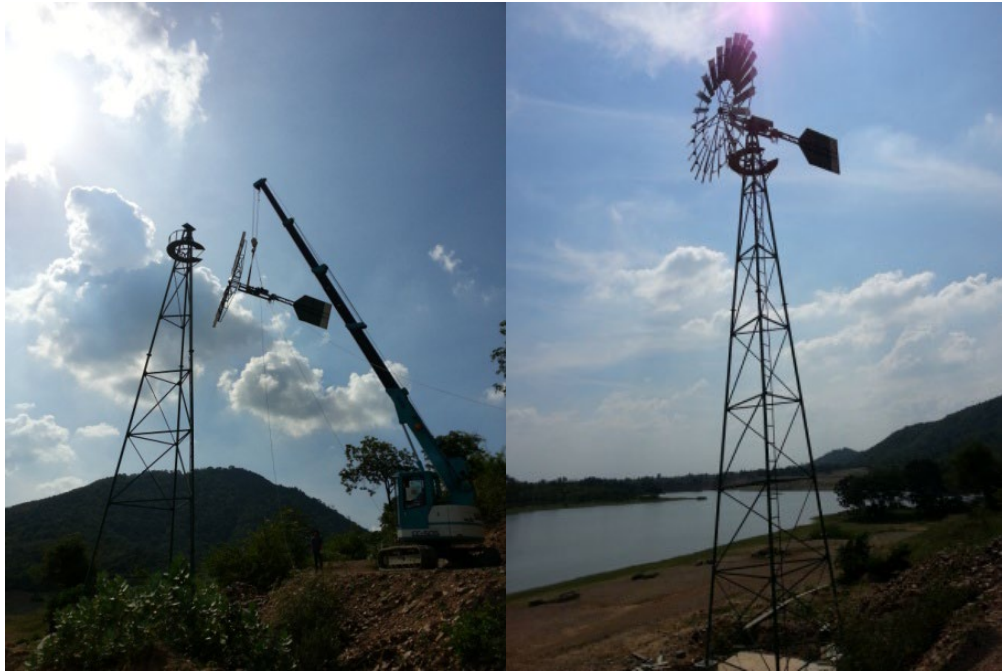
รูปที่ 4-5 การติดตั้งกังหันลม
