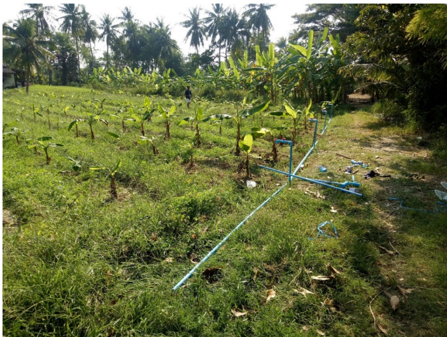
ภาพผนวก 4 แสดงการติดตั้งวางท่อส่งน้ำ PVC ภายในแปลงทดลอง
