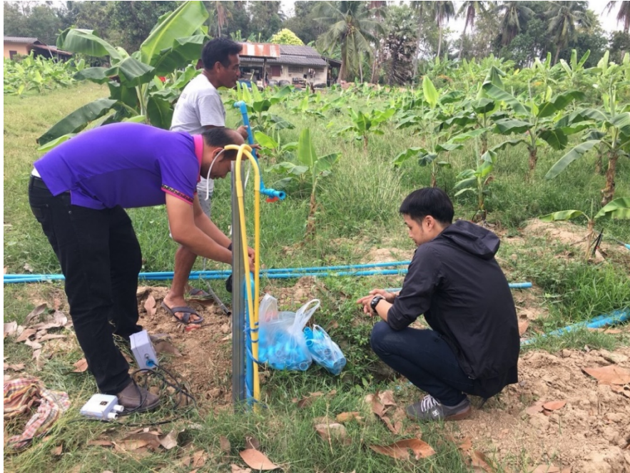
ภาพผนวกที่ 3 แสดงการติดตั้งวางท่อส่งน้ำ PVC ภายในแปลงทดลอง
