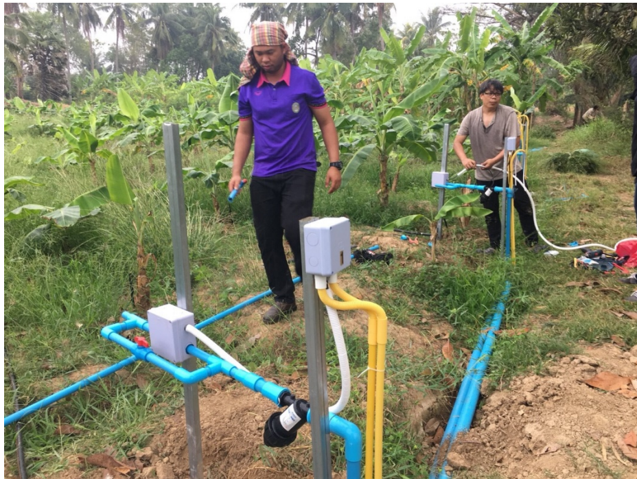
ภาคผนวก 5 แสดงการติดตั้งปั้มน้ำ
