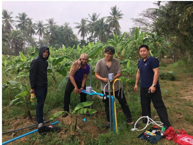
ภาคผนวก 7 แสดงการติดตั้งปั้มน้ำ
