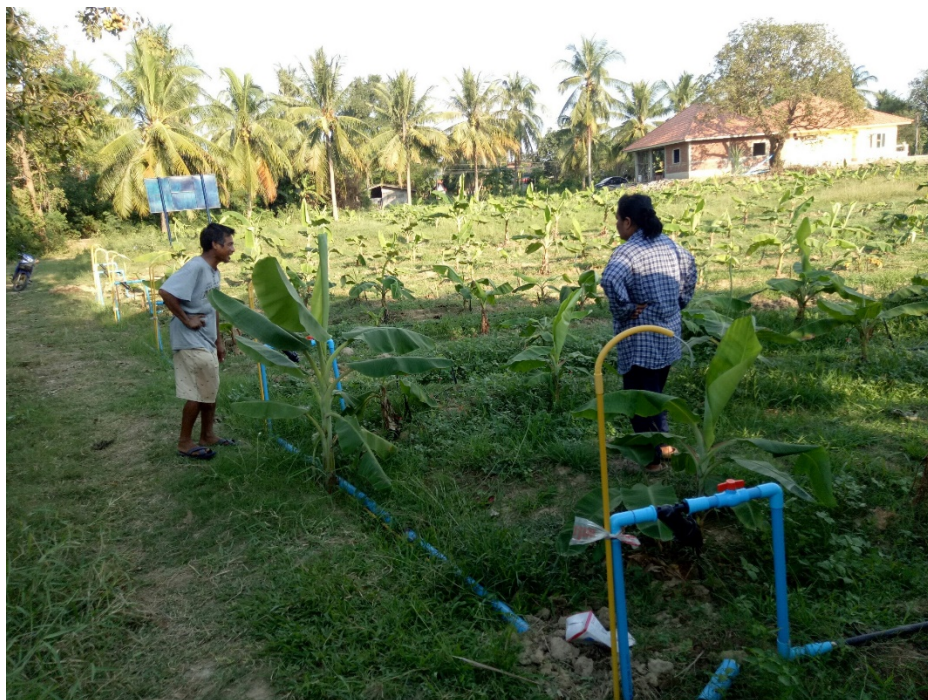
ภาคผนวก 6 แสดงการติดตั้งปั้มน้ำ
