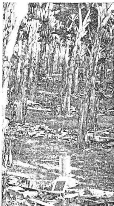
ภาพที่ 4.9 การติดตั้งโหนดฐานและโหนดเซ็นเซอร์
