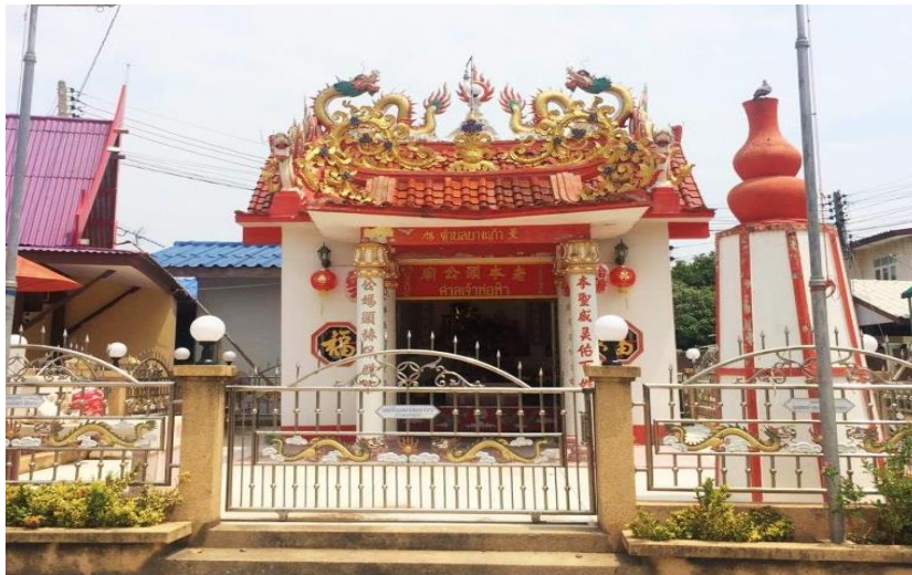
ภาพที่ 4.17 ศาลเจ้าพ่อฟ้า ตำบลบางแก้ว ที่มา : จากการสำรวจ
