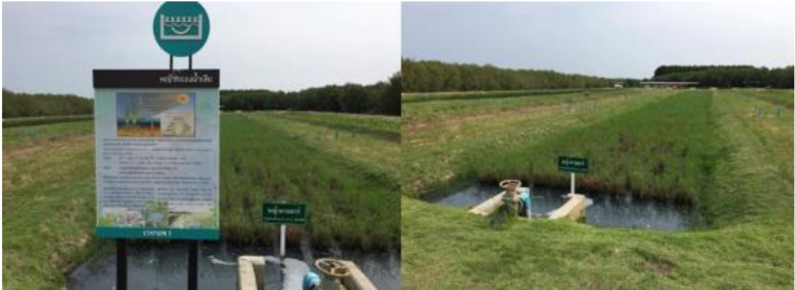
ภาพที่ 6 หล้ากรองน้ำเสีย ที่มา: จากการสำรวจ
